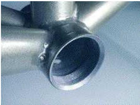
Steht keine feste Kettenstrebe zur Befestigung der Drehmomentstütze zur Verfügung (z.B. bei gefederten Bikes, oft auch bei Falt- und Liegerädern), kann das Tretlagerrohr konisch angefräst werden.
